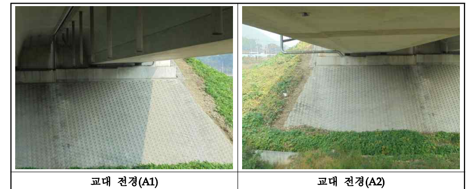
【사진 3.3.7】 교대 전경(부산)
