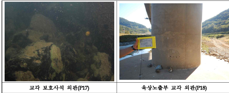
【사진 3.2.11】 교각 수중부 조사 현황(대구,계속)
