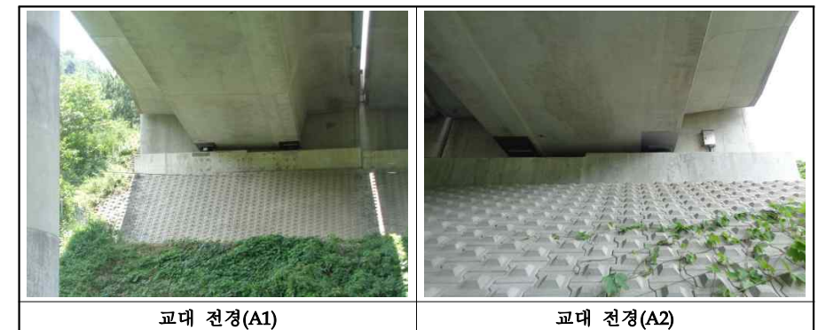
【사진 3.2.7】교대 전경(대구)
