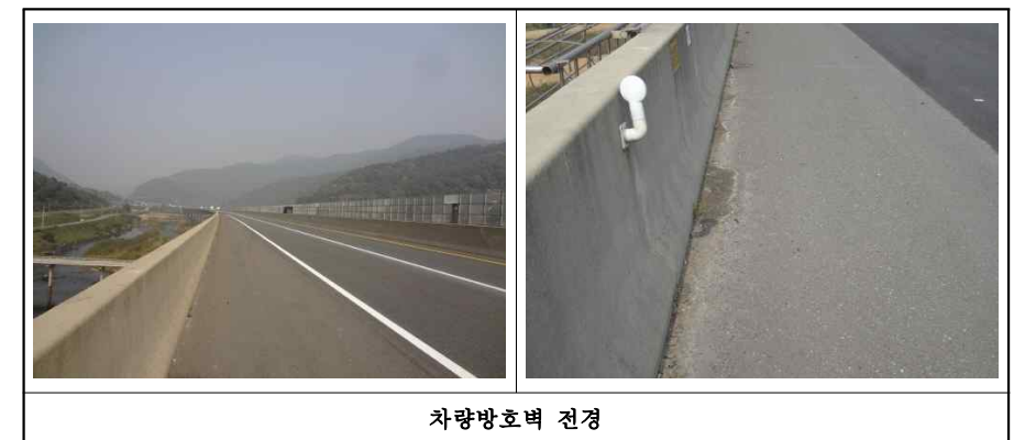
【사진 3.2.20】 방호벽 전경(대구)
