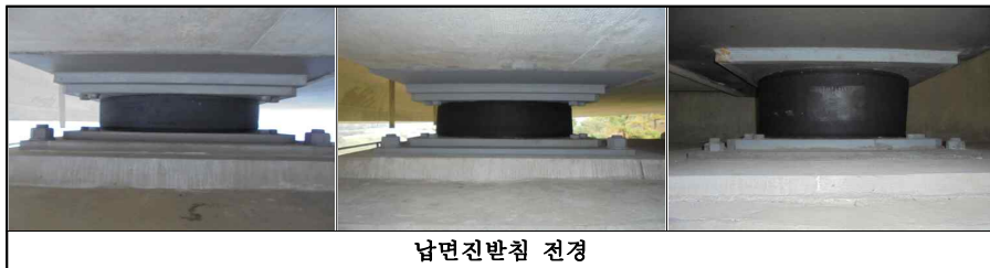
【사진 3.2.12】교량받침 전경(대구)
