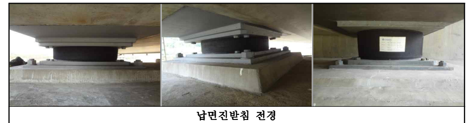
【사진 3.3.12】 교량받침 전경(부산)
