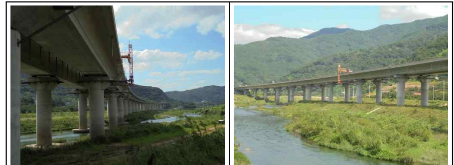
교량점검차를 이용한 조사
