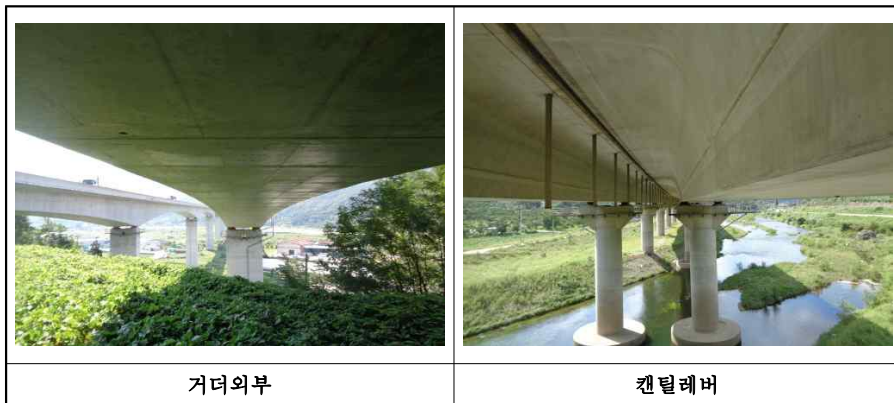
【사진 3.2.1】 거더외부 전경(대구)
