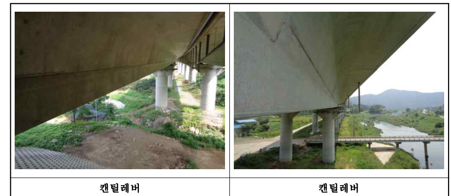
【사진 3.3.1】 거더외부 전경(부산)
