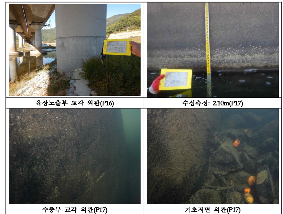
【사진 3.2.11】 교각 수중부 조사 현황(대구)
